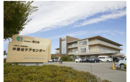
中部台ケアセンター
